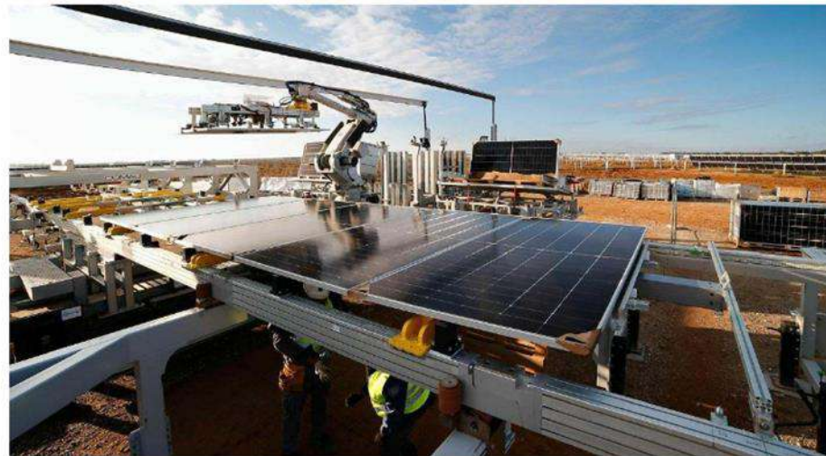
El robot instala de forma autónoma las placas sobre los soportes
